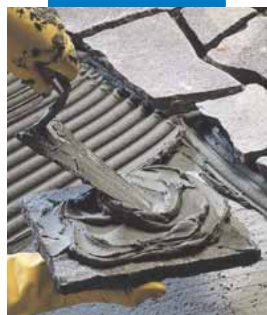
Lepení dlažby z lámaného přírodního kamene bez anebo s "podmazáním" v závislosti na tloušťce
