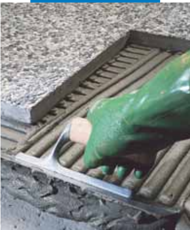
Lepení vymývané betonové dlažby v exteriéru
